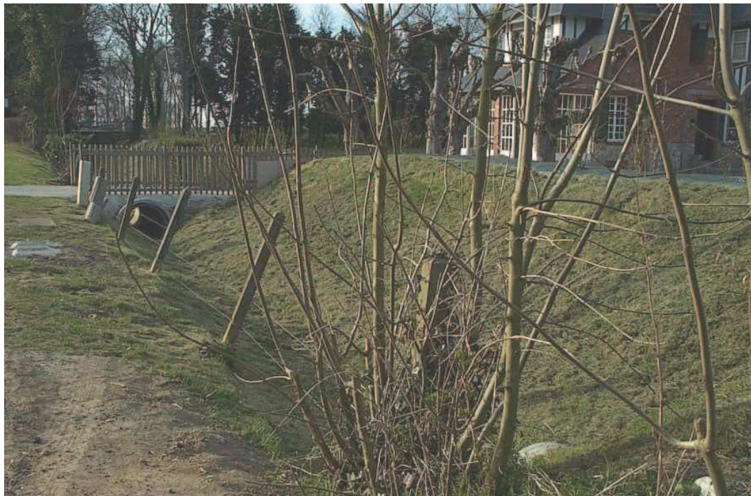
Photo 5 : Fossé le long de la RD à Saint-Aubin-sur-Mer
