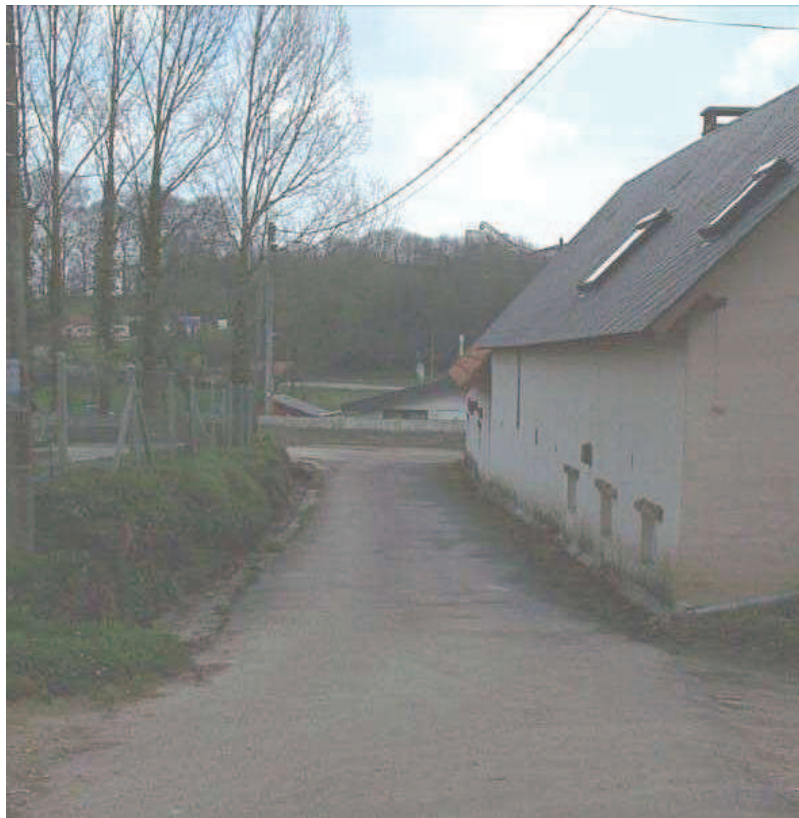
Photo 13 : Habitation menacée par les ruissellements de la cavée Saint-Pierre-le-Viger
