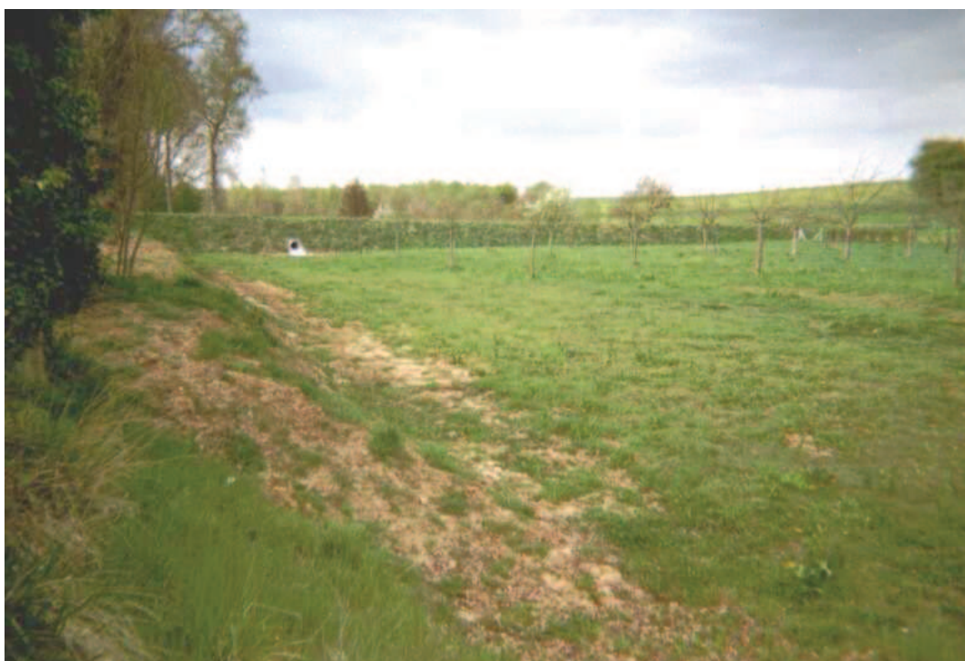
Photo 8 : Bassin de retenue à Blengre (Bourg Dun)
