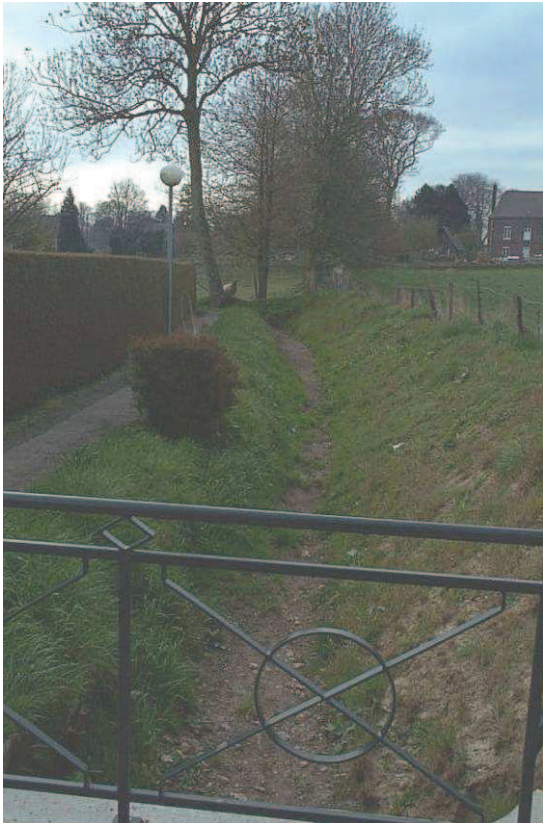
Photo 19 : Fossé drainant les ruissellements et contournant les habitations à Crasville
