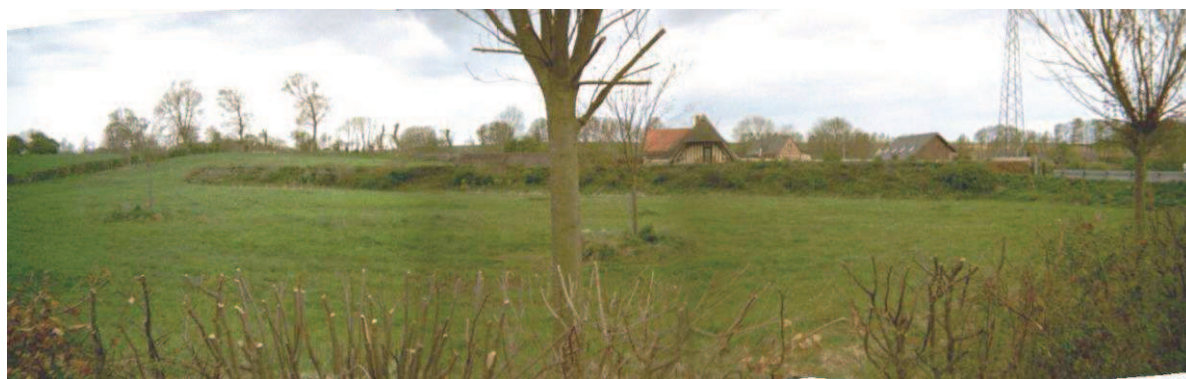
Photo 6 : Digue de protection le long d'une propriété à Blengre (Bourg Dun)
