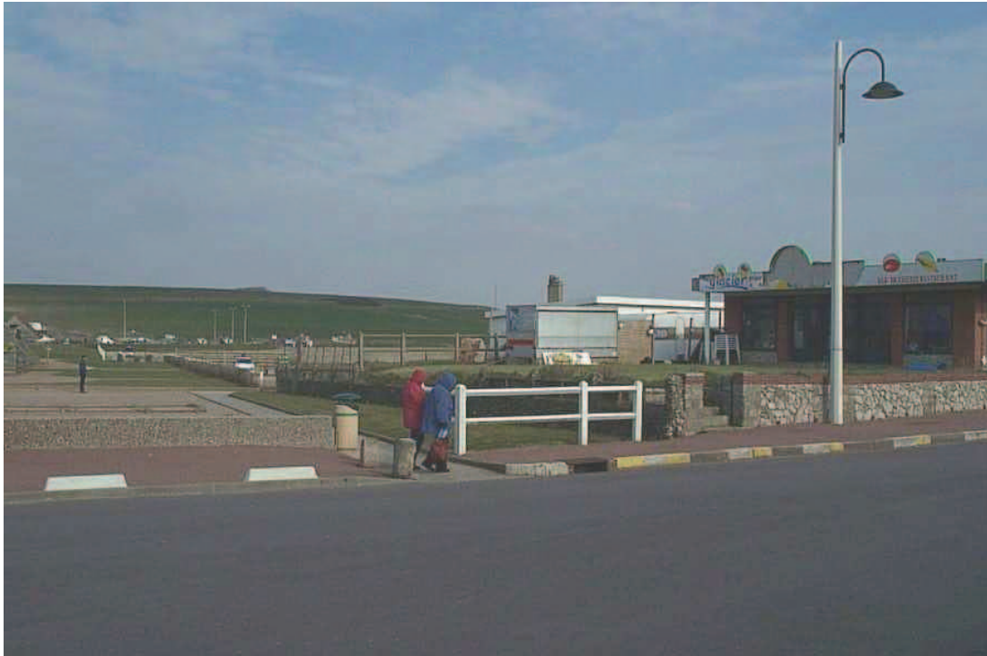
Photo 4 : Buvette sur remblai à Saint-Aubin-sur-Mer
