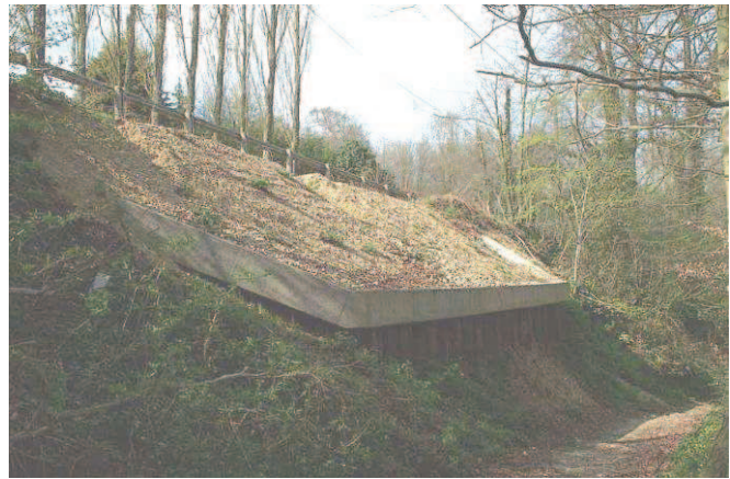
Photo 10 : Soutènement de la RD 4 à la Gaillarde
