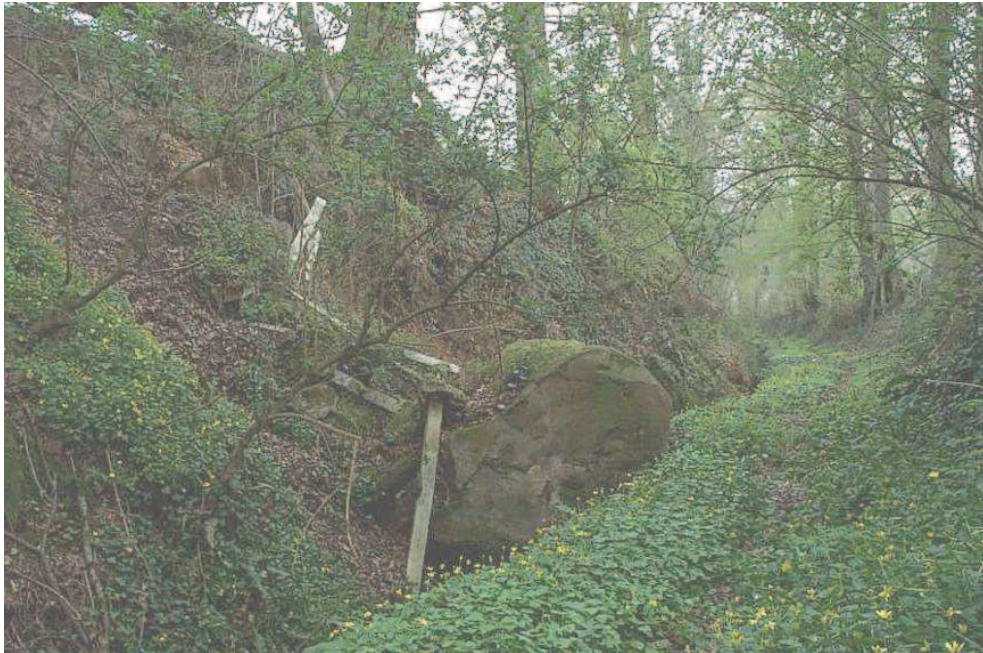
Photo 12 : Cavée dangereuse à Saint-Pierre-le-Viger
