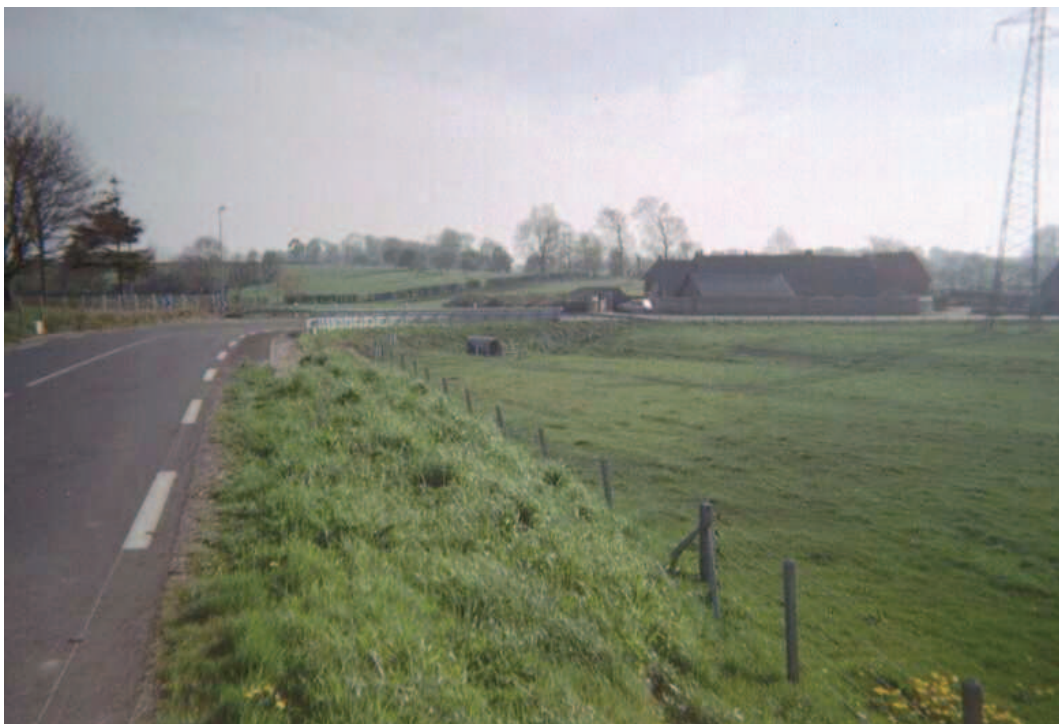
Photo 7 : Ouvrage hydraulique de la RD à Blengre (Bourg Dun)
