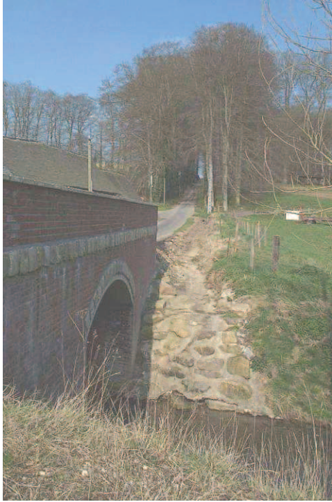
Photo 11 : Pont refait à la Gaillarde
