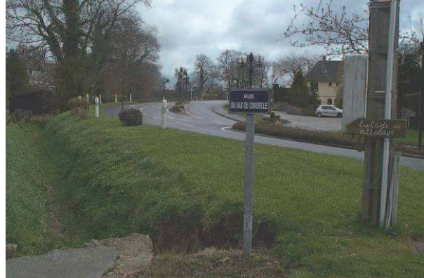
Photo 14 : RD 142 drainant les eaux de plusieurs bassins versants vers le Dun
